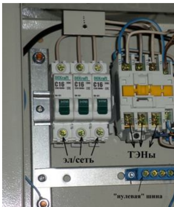
Рисунок 2 – Подключение к эл/сети и электрическим ТЭНам
